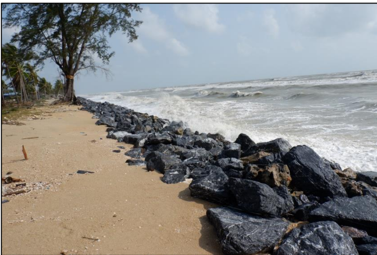
รูปที่ 39 เชื่อนหินทิ้ง
