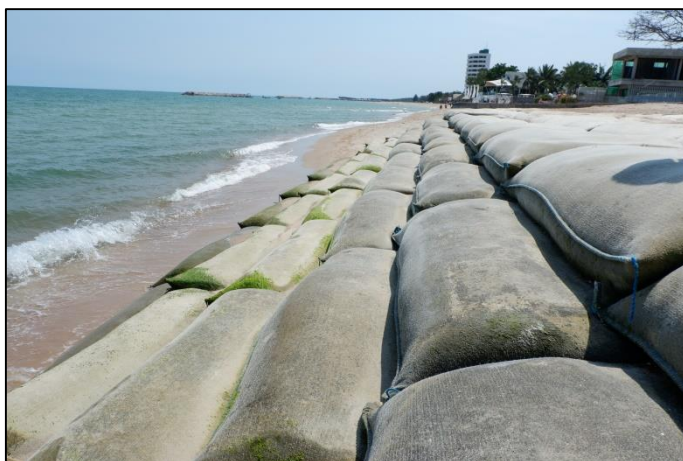
รูปที่ 38 ถุงใยสังเคราะห์
