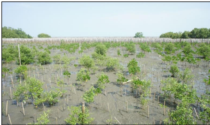
รูปที่ 30 การปักไม้ไผ่ในพื้นที่หาดโคลน เพื่อชะลอความรุนแรงของคลื่น
