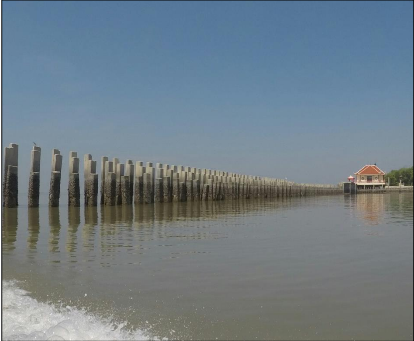
รูปที่ 33 เสาคอนกรีตป้องกันคลื่นนอกชายฝั่ง
