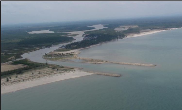
รูปที่ 24 เชือกกันทรายและคลื่นปากแม่น้ำ (Jetty)
